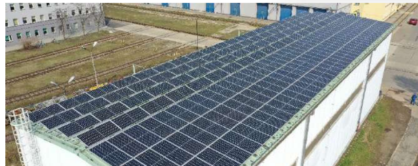
Budowa instalacji fotowoltaicznej
